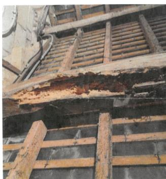
Restauration d'une poutre très endommagée au niveau de la sacristie avec traitement de la charpente
