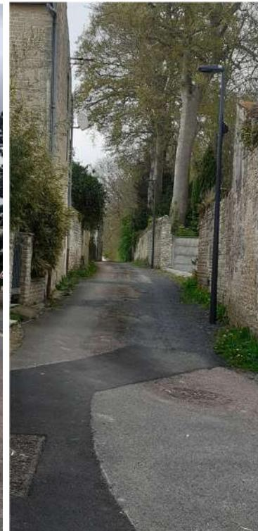
Tous les poteaux – béton et bois - ont été démantelés ; des reprises d'enrobé ont été effectuées dans l'attente d'une réfection de chaussée dans le courant de l'année 2024.
